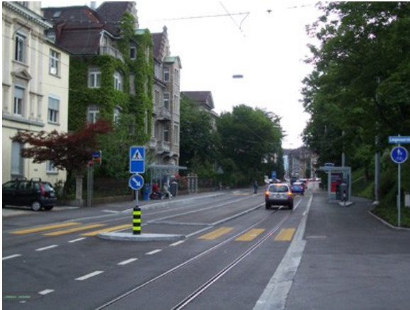
Weinbergstrasse. Haltestelle mit durchgehender Mittelinsel und Querung für Fussverkehr.
