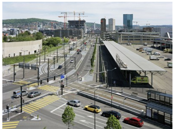
Pfingstweidstrasse. Freie Strecke mit Mittelinsel und seitlichem Tramtrassee. (Fotografarin: Andrea Helbling)
