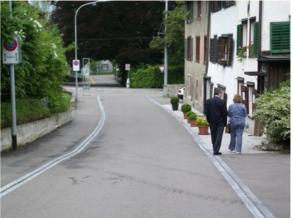
Huttensteig. Mischverkehrsfläche auf gleichem Niveau Hinterbergstrasse. Beidseitiger Randabschluss mit minimalem Anschlag in Tempo-30-Zone.
