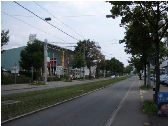
Badenerstrasse. Freie Strecke mit Tram auf breitem Grüntrassee und Allee.
