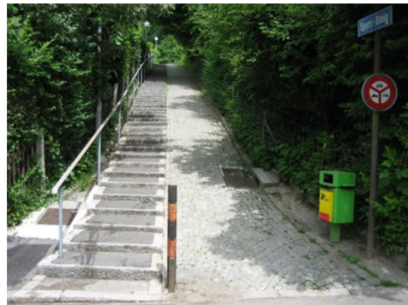
Spyri-Steig. Treppenweg gepflästert, mit Handlauf und Schieberampe, abgegrenzt durch Sträucher und Hecken.
