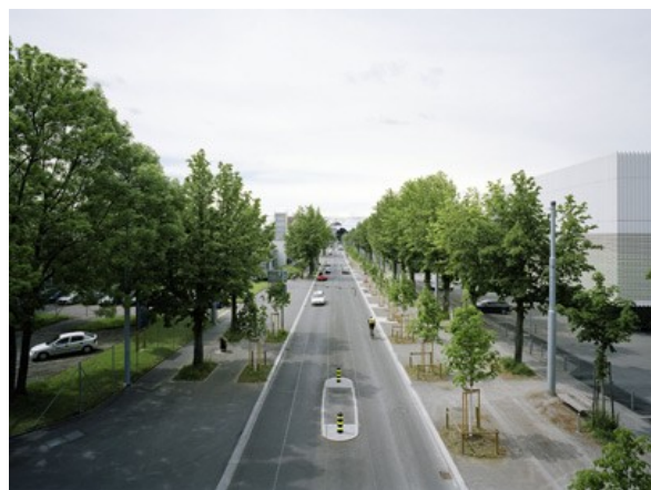
Bullingerstrasse. Fahrbahn mit Mittelinsel als Querungshilfe. (Fotografarin: Andrea Helbling)
