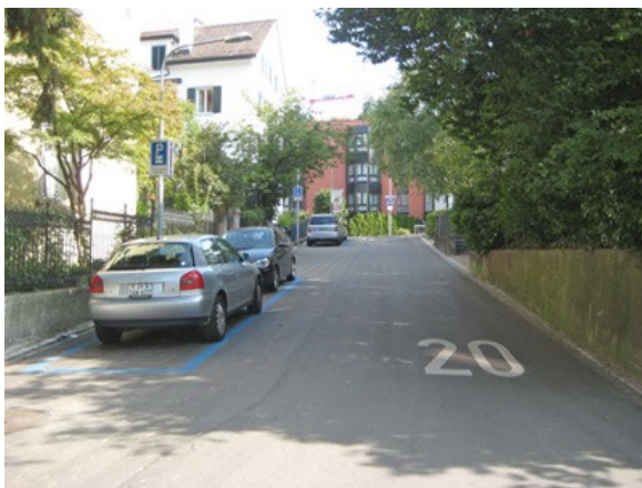
Huttensteig. Mischverkehrsfläche auf gleichem Niveau ohne Kennzeichnung der Fahrbahn in Begegnungszone.
