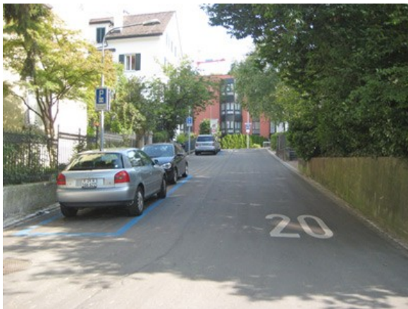
Huttensteig. Mischverkehrsfläche auf gleichem Niveau ohne Kennzeichnung der Fahrbahn in Begegnungszone.
