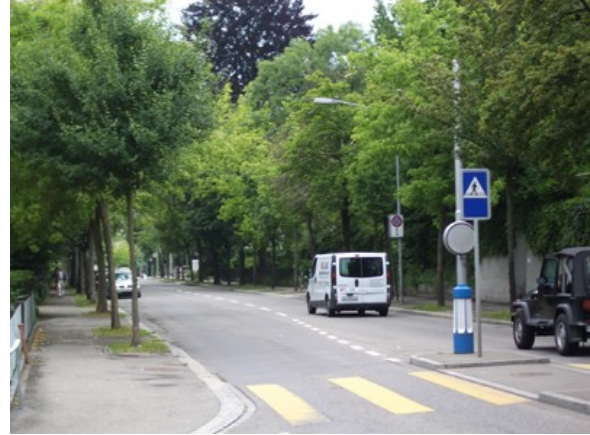
Gladbachstrasse. Allee, Querungen mit Mittelinsel für den Fussverkehr.
