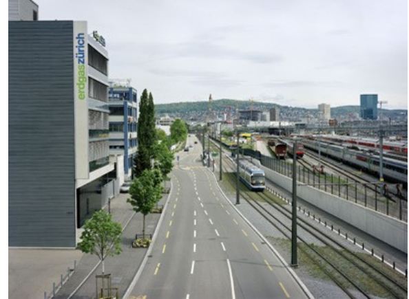
Aargauerstrasse. Freie Strecke mit teilbegrüntem Trassee und Baumreihe. (Fotografin: Andrea Helbling)
