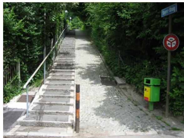
Spyri-Steig. Treppenweg gepflästert, mit Handlauf und Schieberampe, abgegrenzt durch Sträucher und Hecken.
