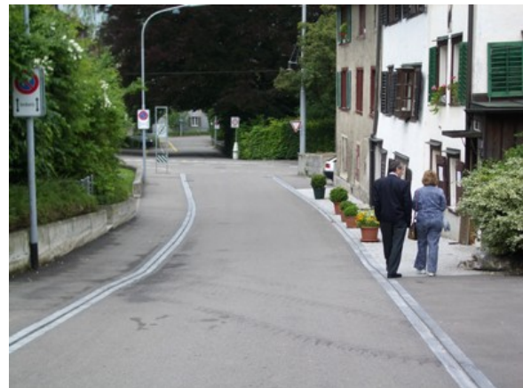
Hinterbergstrasse. Beidseitiger Randabschluss mit minimalem Anschlag in Tempo-30-Zone.
