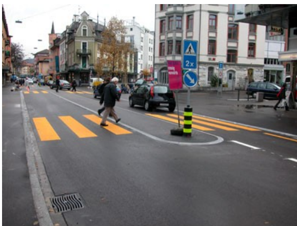
Franklinplatz. Überfahrbare Mehrzweckstreifen als Querungshilfe im Zentrum Oerlikon.
