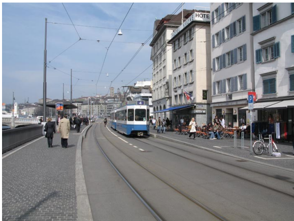
Limmatquai. Tram in Fahrverbotszone, beidseitige Randabschlüsse mit minimalem Anschlag und Elementen.
