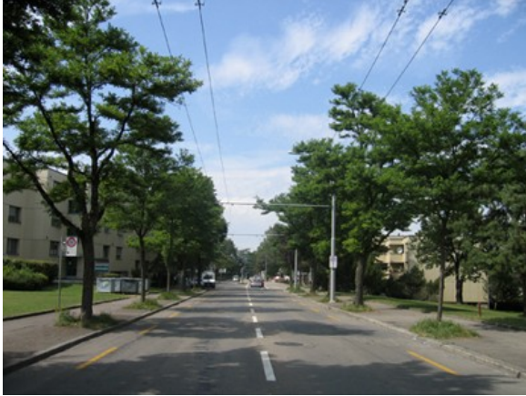
Schweighofstrasse. Freie Strecke mit Allee.
