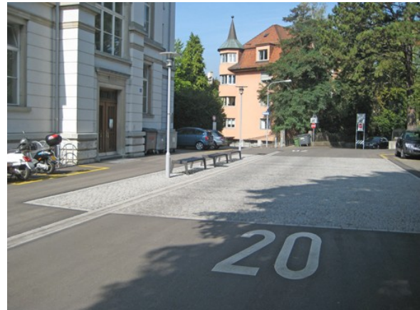
Huttenstrasse. Seitlich längs verlaufende Friesstreifen (ein- und dreireihig), Platzgestaltung mit Granitpflasterung auf gleichem Niveau in Begegnungszone.
