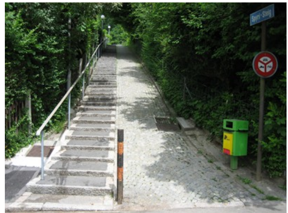
Spyri-Steig. Treppenweg gepflastert, mit Handlauf und Schieberampe, abgegrenzt durch Sträucher und Hecken.
